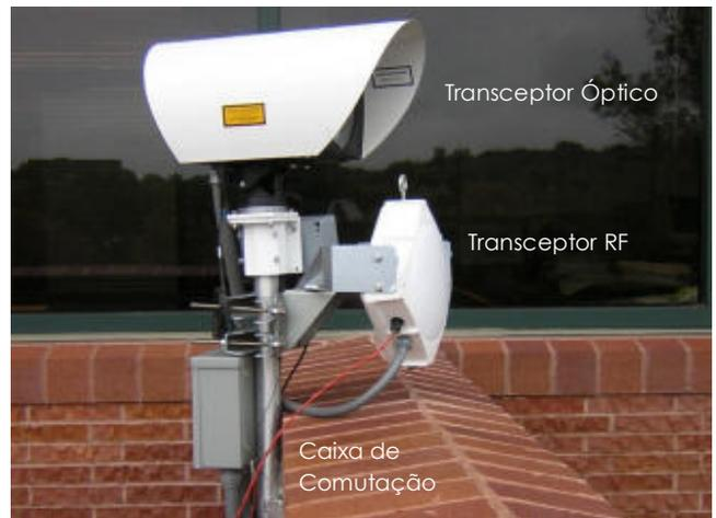
Fig.6: Sistema Híbrido comercializado pela BeamWave<sup>®</sup>. Observa-se o transceptor de RF de 60 GHz e a caixa de comutação instalada junto ao sistema FSO original [8].
