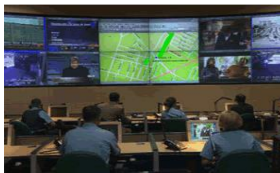
Fig 5 .: Exemplo de Centro de Comando e Controle Fixo (12)
