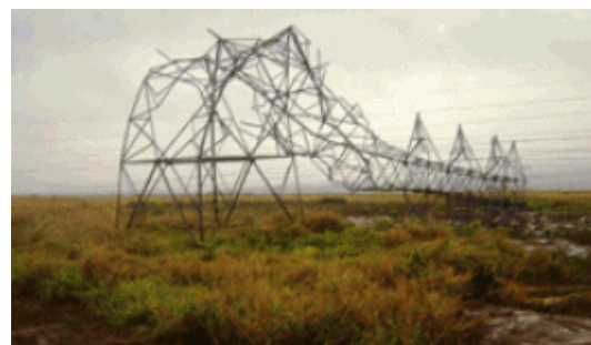
Fig. 2. Torre de alta tensão danificada por carga de vento [10].
