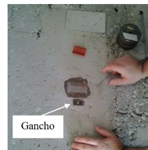
Fig. 3. Fixação dos ganchos no fundo das lajes.
